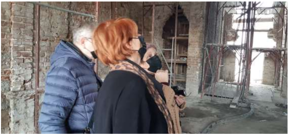
Reabilitarea monumentului istoric și de arhitectură „Conacul Bolomey”, cod LMI: IL-II-a-A-14106.
