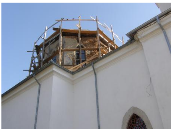
6. Lucrări de conservare-restaurare a picturii murale originare și execuție pictură din nou de la Biserica „Sf. Împărați”, cod L.M.I.: IL-II-m-B-14154, sat Piersica, com. Ciocina.
