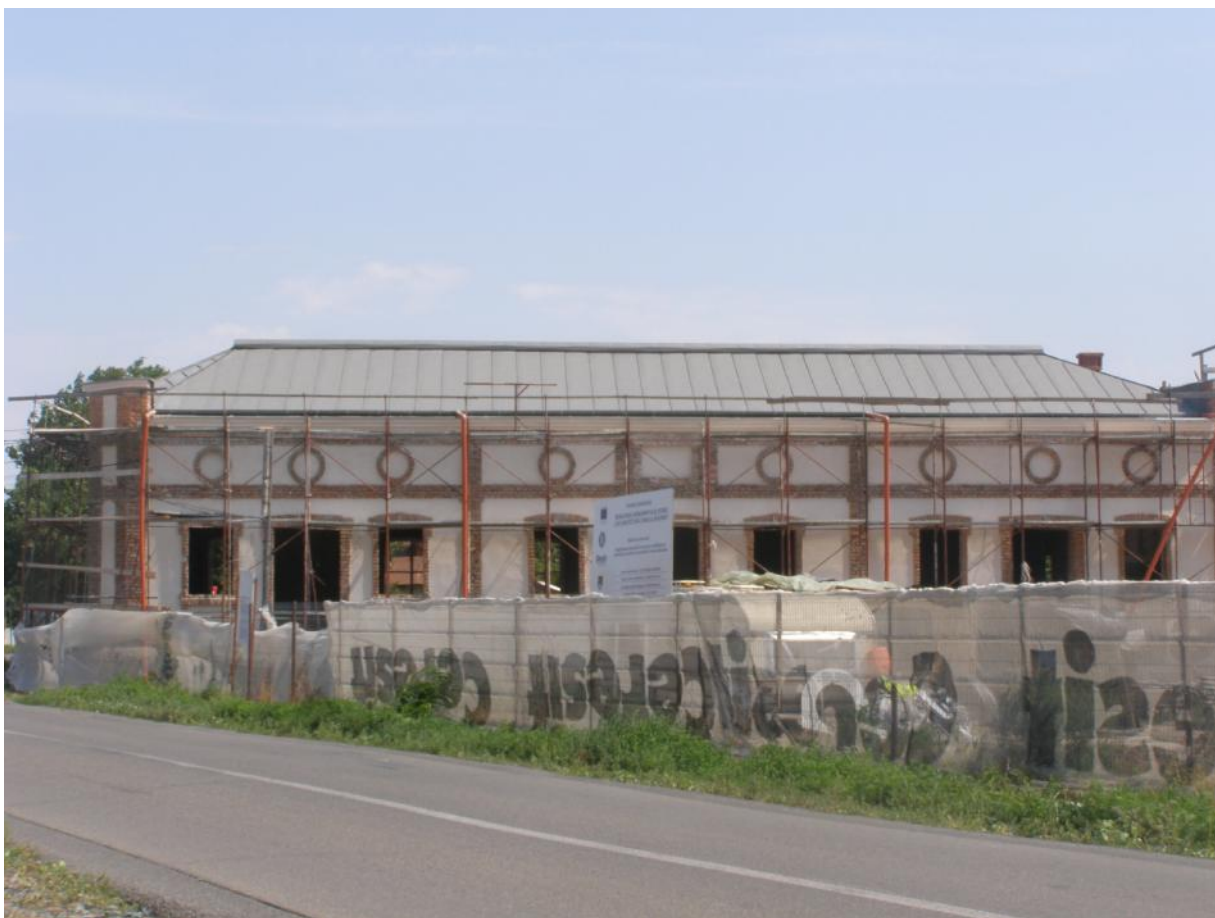
4. Biserica „Sfinții Voievozi”, Țândărei, cod L.M.I. : IL-II-m-B-14164, lucrări privind: Îmbunătățirea mediului urban prin conservarea, protecția și valorificarea durabilă a obiectivului Parohia „Sfinții Voievozi Țândărei;
